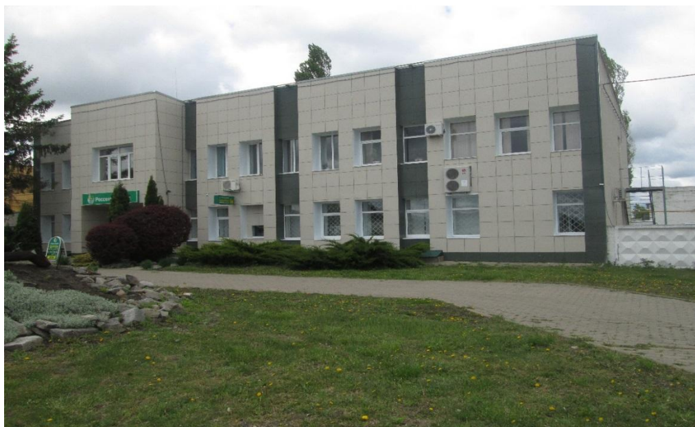
Рис. 2.3. Фасад здания ООО «Ракитянский водсервис»
